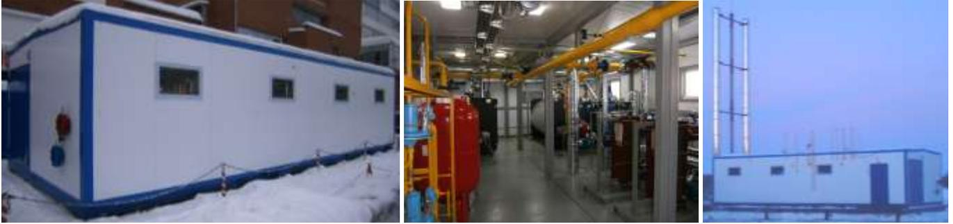
6. Дизельная модульная (контейнерная) водогрейная котельная мощностью 1000 кВт для отопления производственной базы (Рудник «Валунистый», Чукотка). Выполнено: Изготовление котельной (с комплектацией), транспортировка на место, монтаж, пусконаладочные работы, обучение персонала.
