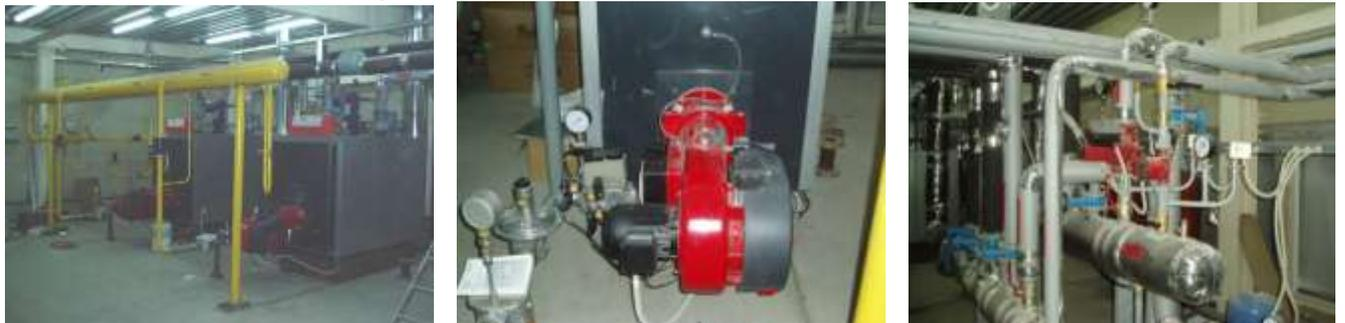
3. Газовая модульная водогрейная котельная установленной мощностью 3200 кВт для отопления Промышленной базы предприятия (Филиал ООО «АРГОС»-КЕДР г. Когалым). Выполнено: Изготовление котельной (с комплектацией), доставка на место, монтаж, ПНР, обучение персонала, ТО котельной.
