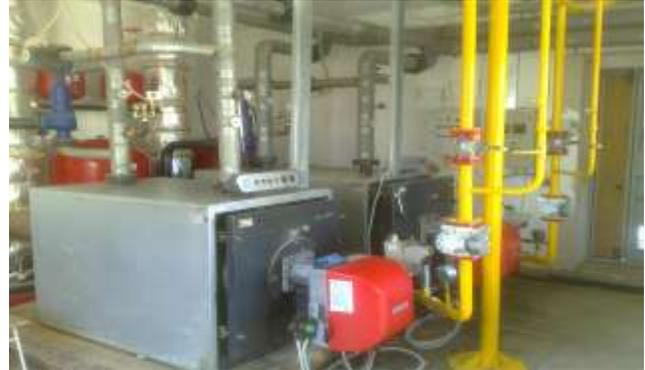
12. Модульная контейнерная водогрейная котельная мощностью 1200кВт на мазуте (нефти) со встроенными ДГУ и стабилизатором напряжения для отопления торгового комплекса («Строитель 88», г.Нижневартовск). Выполнены: Изготовление котельной (с комплектацией), доставка, монтаж, ПНР, обучение.
