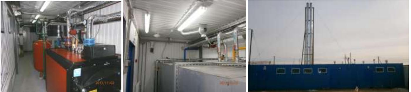
8. Дизельная модульная (контейнерная) водогрейная котельная мощностью 1000 кВт для отопления производственной базы (Газ-Сале, ЯНАО). Выполнено: Изготовление котельной (с комплектацией), транспортировка на место; монтаж, пусконаладочные работы, обучение персонала.
