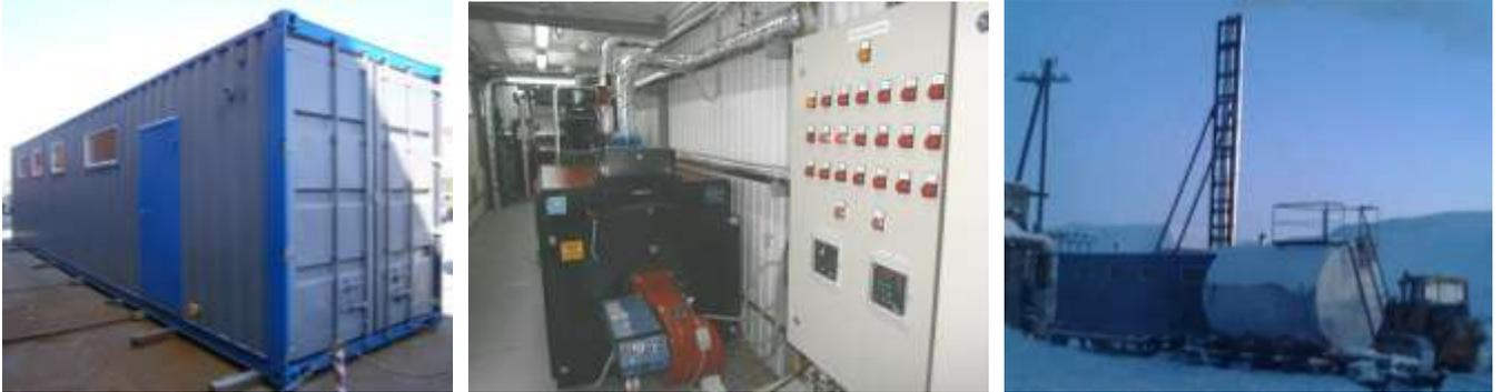
7. Модульная (контейнерная) водогрейная котельная мощностью 1000кВт на отработанном масле в комплекте с блоком топливоподготовки для отопления производственных объектов (Арх.обл., Примор. район, в/п Светлый). Выполнено: Изготовление котельной и блока топливоподготовки (с комплектацией), доставка на место, монтаж, ПНР, обучение персонала.
