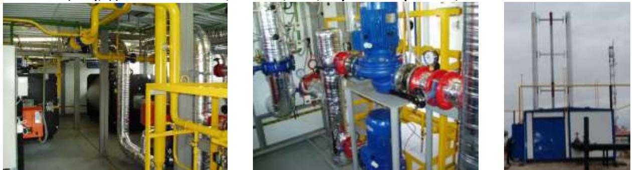
4. Резервная модульная паровая котельная производительностью 1350 кг пара в час (930 кВт) на дизельном топливе для технологических нужд предприятия Концерна «АЛРОСА» (Якутия, Накын). Выполнено: Изготовление котельной (с комплектацией), транспортировка на место, монтаж, ПНР, обучение.
