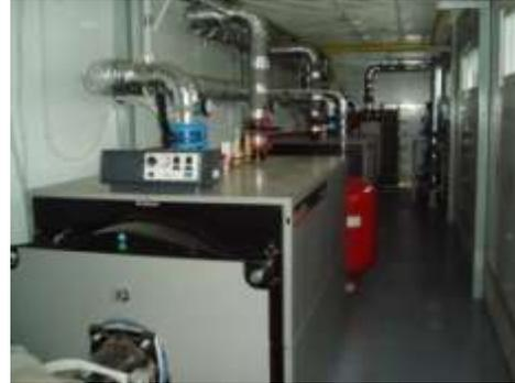
11. Выполнение ревизии оборудования котельной, монтаж оборудования КИПиА, газовых горелок с рампами, врезка и установка датчиков, приборов и арматуры, изготовление топливопровода резервного топлива, пусконаладочные работы котельной мощностью 700 кВт (с двумя котлами "Protherm") для ООО «Строительные технологии», г.Березовск, Свердловской области.
