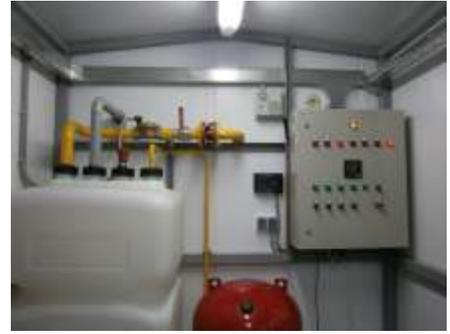
10. Модульная газовая водогрейная котельная мощностью 1200 кВт для отопления промышленного предприятия (ОАО «НТ МИЗ» г.Н.Тагил). Выполнено: Изготовление котельной (с комплектацией), доставка на место автотранспортом, монтаж, пусконаладочные работы, обучение персонала.
