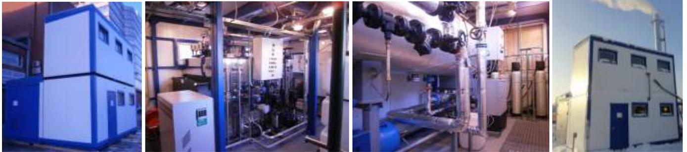
2. Крышная газовая водогрейная котельная торгового центра мощностью 1120 кВт для отопления торгового центра (ООО «Анкор» г.Н.Уренгой, ЯНАО). Выполнено: Монтаж оборудования (с комплектацией), сборка и изготовление на месте, настройка, пусконаладочные работы.
