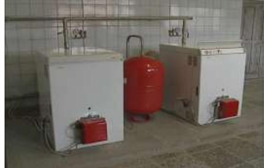
19. Модульная водогрейная котельная мощностью 1700 кВт на дизельном топливе для отопления жилых объектов на полуострове Камчатка (МУП «Дары природы», г. Петропавловск-Камчатский). Выполнено: Изготовление котельной (с комплектацией), транспортировка на место железной дорогой и морем.
