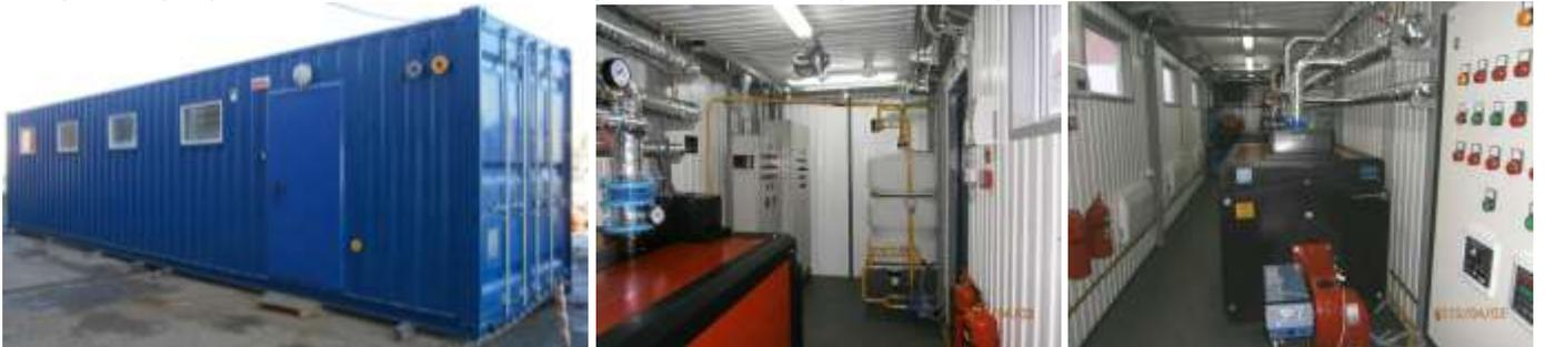
9. Модульная водогрейная котельная мощностью 93кВт на дизельном топливе для отопления производственного объекта транспортного предприятия Южно-Уральской железной дороги в г.Челябинске. Выполнено: Изготовление котельной (с комплектацией), доставка на место, инженерная поддержка.
