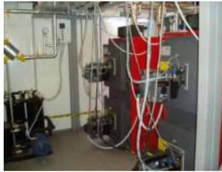
14. Модульная водогрейная котельная мощностью 600 кВт на отработке, мазуте, нефти для отопления Промышленной базы транспортного предприятия в г. Покачи (ООО «ТрансСпецСервис», г.Уфа).
