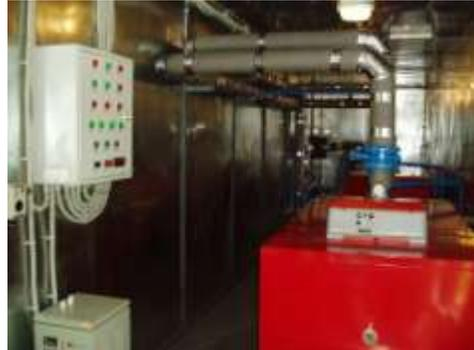
16. Модульная водогрейная котельная мощностью 500 кВт на дизельном топливе (в здании из сэндвич-панелей) для отопления и горячего водоснабжения средней общеобразовательной школы в г.Верхотурье (МУП «Юность Урала», г.Екатеринбург).
