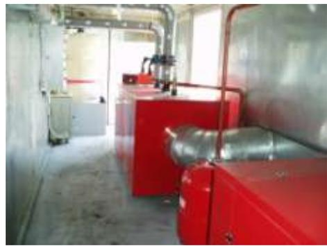
18. Производственные водогрейные котельные на базе котлов DAKON Prchal и NM для мебельной фабрики (ООО «Люкс Фронт» г. Асбест). Выполнено: Монтаж оборудования (с комплектацией), изготовление котельных на месте, пусконаладочные работы, обучение персонала, ТО.
