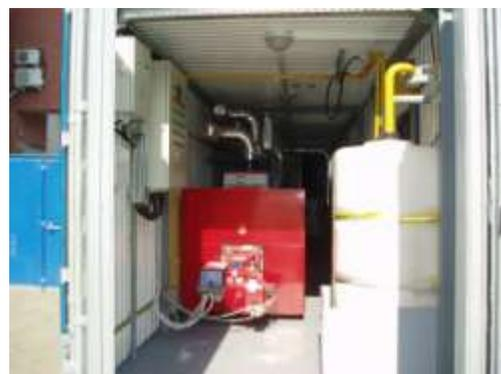
**21. Встроенная водогрейная котельная на дизельном топливе мощностью 180 кВт пожарной части (г.Камышлов Свердловской области). Выполнено: Изготовление котельной на месте (с комплектацией), ПНР, обучение персонала.**
