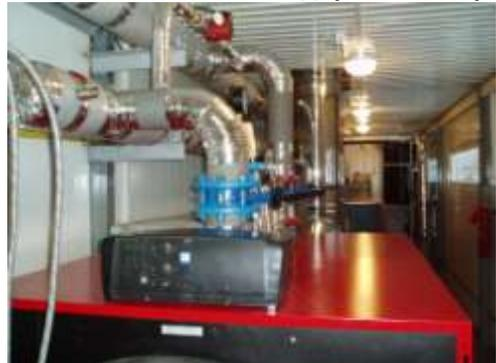
20. Мобильная водогрейная контейнерная котельная мощностью 1540 кВт на дизельном топливе для отопления жилых объектов в зоне чрезвычайных ситуаций на полуострове Камчатка (МУП «Дары природы», г. Петропавловск-Камчатский). Выполнено: Изготовление котельной (с комплектацией), доставка на место железной дорогой и морем.
