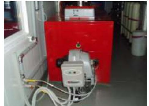
13. Модульная водогрейная котельная мощностью 906 кВт на отработке, мазуте, нефти для отопления Промышленной базы предприятия (ООО «Градиент-Энерго», г.Ноябрьск). Выполнено: Изготовление котельной (с комплектацией), доставка на место, монтаж, ПНР, обучение персонала.
