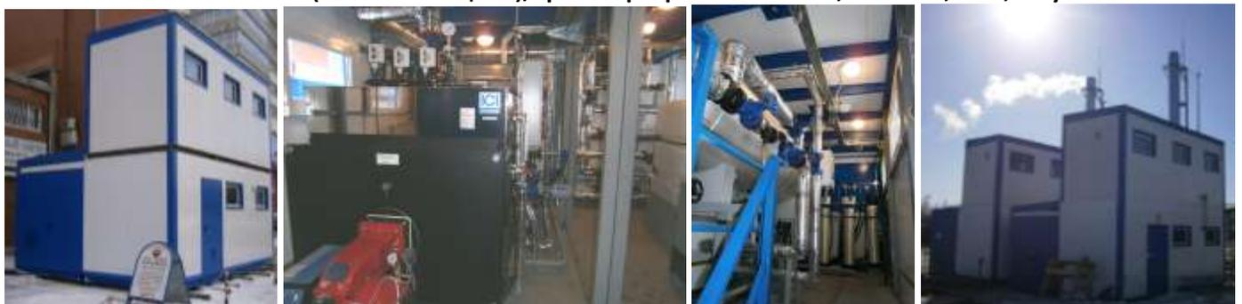
5. Газовая модульная водогрейная котельная установленной мощностью 3200 кВт для отопления Производственной базы предприятия (Филиал ООО «АРГОС»)-ПРОМЕТЕЙ г. Когалым). Выполнено: Изготовление котельной (с комплектацией), транспортировка на место, монтаж, ПНР, обучение персонала.
